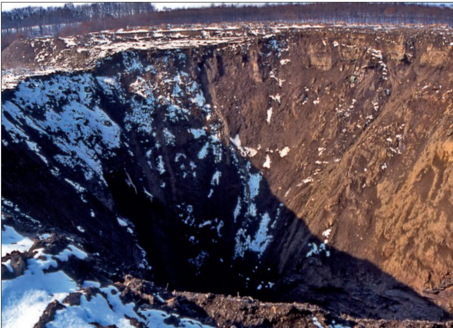
**Abb. 11:** Kalkwerk Braunsdorf, Tagesbruch während der Verfüllungsarbeiten im Februar 1996 (Foto: J. Pfeifer).
