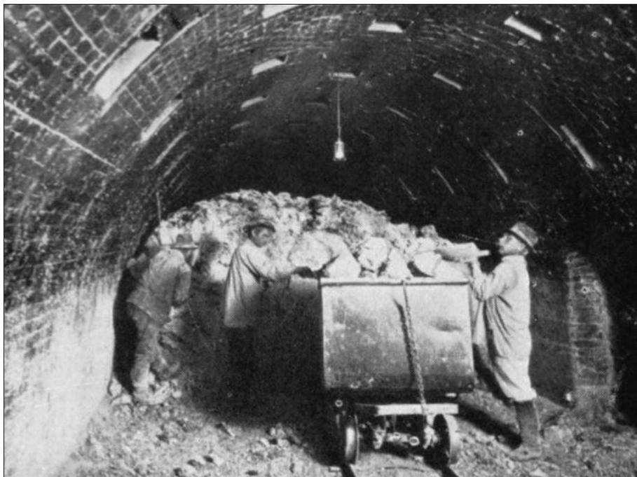
**Abb. 7:** Kalkwerk Braunsdorf, Entleerung des Ringofens (Foto: P. Schulz, 1930).
