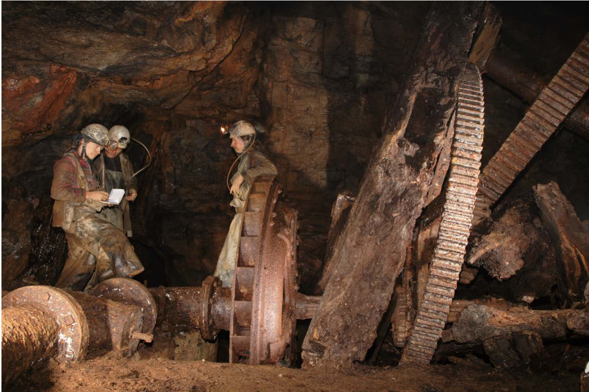
Abb. 6: Schwamkrugturbine für den Antrieb der Fahrkunst im Thurmhofschacht.
