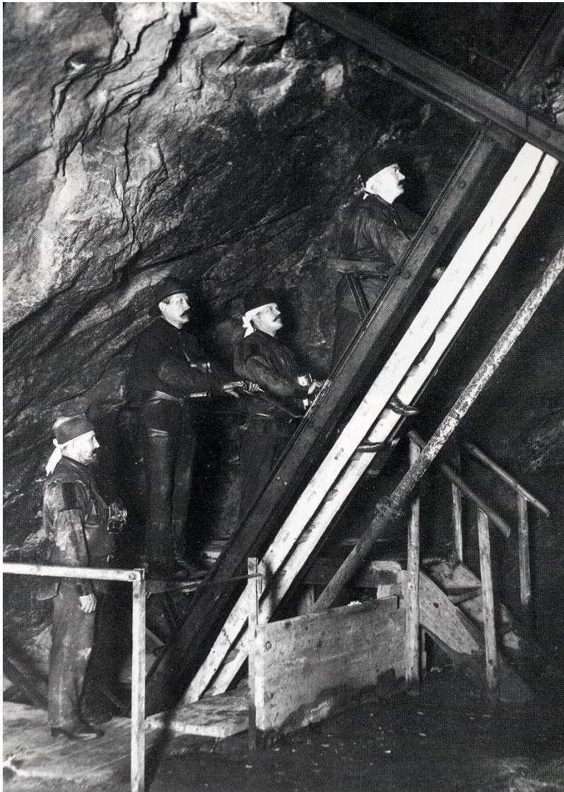
Abb. 10: Bergleute auf der oberen Fahrkunst im Frankenschacht der Grube Himmelsfürst. Foto: Aus Dietrich, Maruschke, 2009
