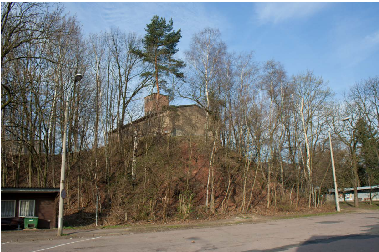
Abb. 5: Rote-Grube-Richtschacht mit dem nach 1945 erbauten Treibehaus. Foto: J. Pfeifer 2007
